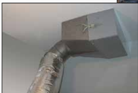
Montagevoorbeeld luchtverdeelkast voor gebalanceerde ventilatie
