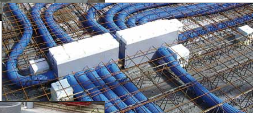
Montagevoorbeeld luchtverdeelkast voor luchttoevoer
