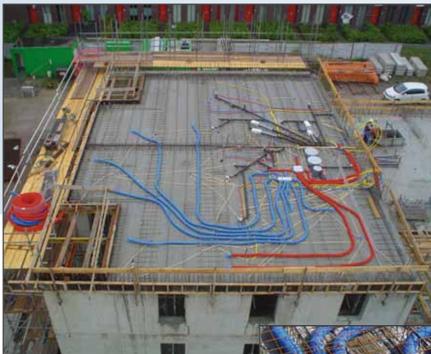
Montagevoorbeeld HybalansPlus-systeem
