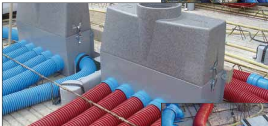
Montagevoorbeeld luchtverdeelkast voor gebalanceerde ventilatie
