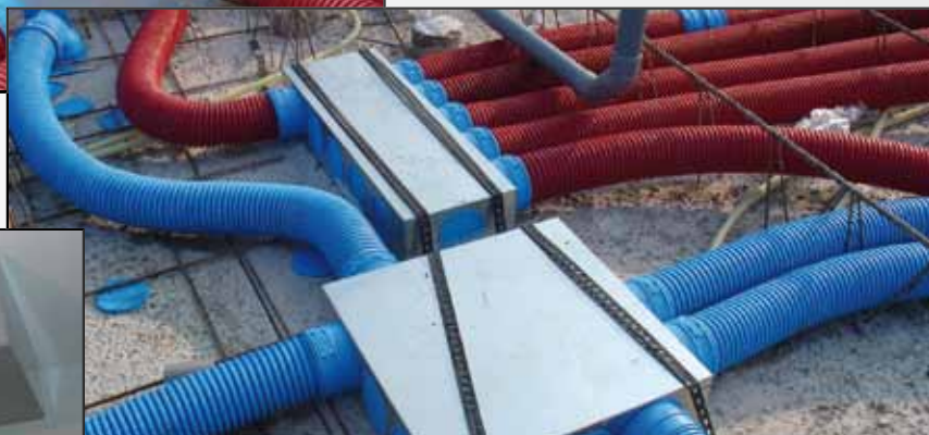
Montagevoorbeeld luchtverdeelkast haaks/recht met aanzuigplenum 400 x 400
